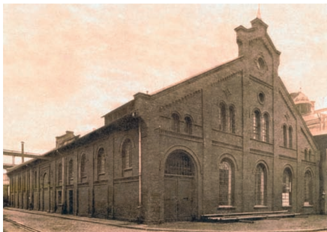
Budynek piecowni w okresie międzywojennym
